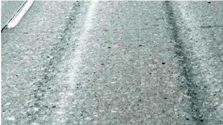
სურ. 1. საფარის დამახასიათებელი ცვეთა სატრანსპორტო საშუალებების მაღალჩქაროსნული ნაკადის მოქმედებისგან. მოცემული უბანი უმეტესი დროის განმავლობაში გაწყლოვანებულ მდგომარეობაშია.
